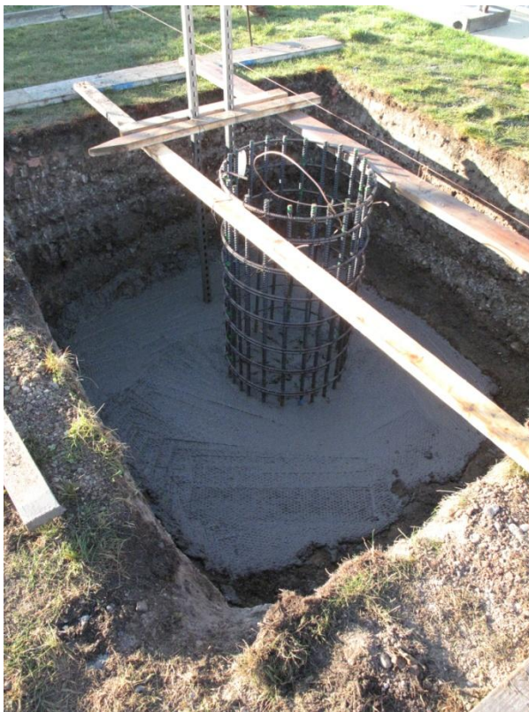
First Concrete Pour Complete
