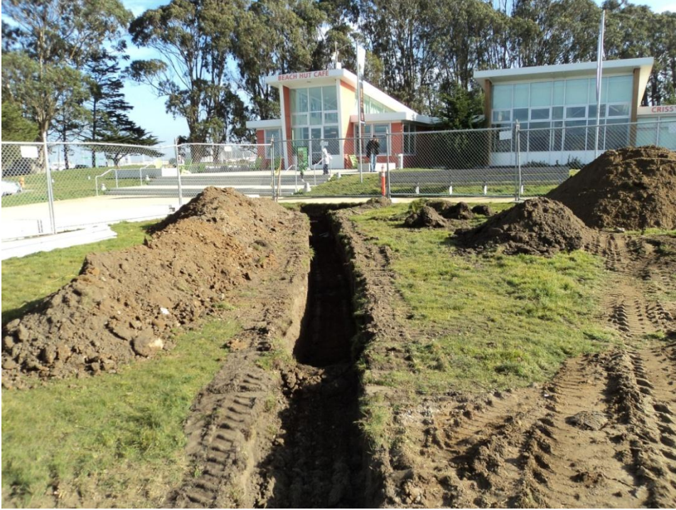
Main Electrical Conduit Trench
