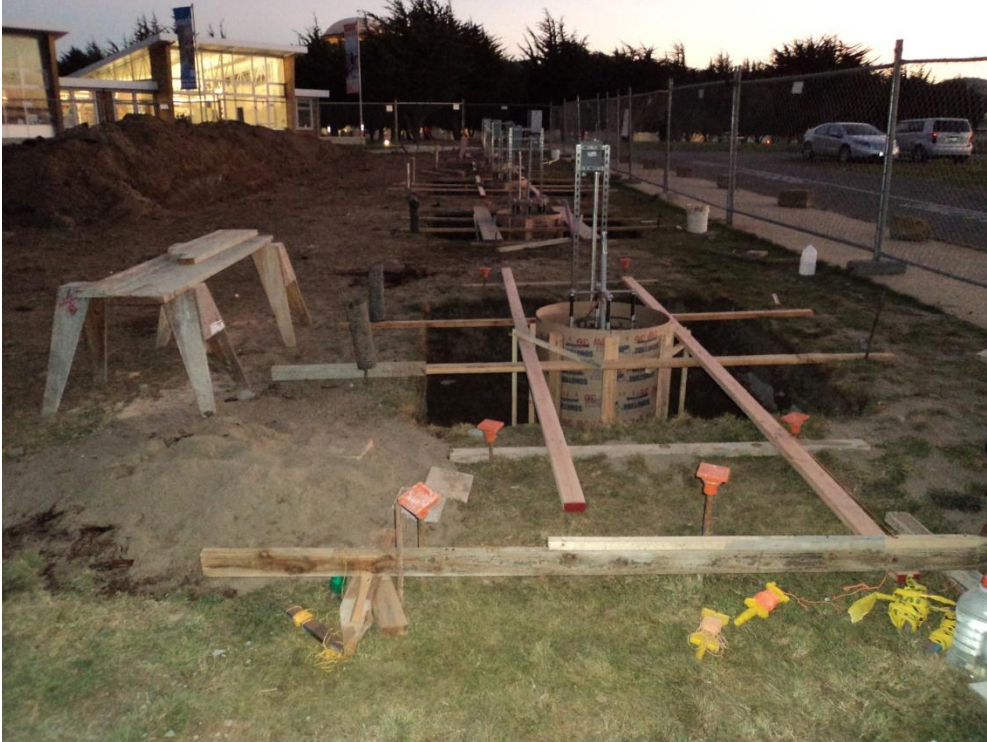
Second Concrete Pour Forms Pepered
